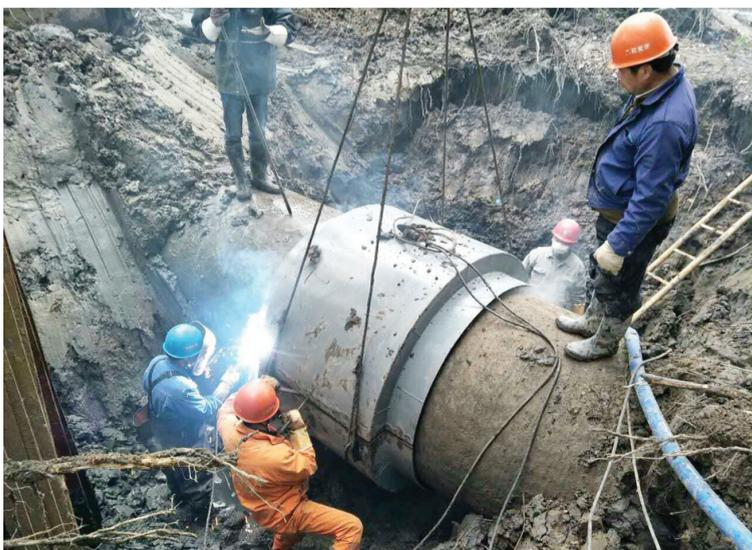
▲同日，排水公司抢修人员在灵芝镇七里江村紧张抢修中心至齐贤泵站DN1200工业污水管。经过11个小时连续奋战，于当晚19点抢修完毕，确保了华舍、钱清及柯东等区块的印染企业污水正常排放。(排水公司 鲁华丽 摄)
